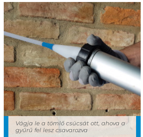
Helyezzen egy kartust a kinyomópisztolyba, majd vágja le a kartus szélét azon az oldalon, ahol a gallér lesz rögzítve
