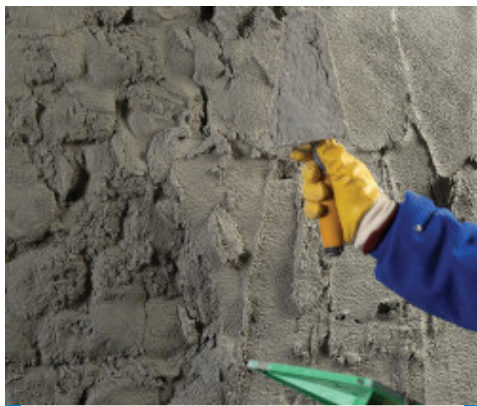
A PoroMap Szárítóvakolat felhordása simítóval
