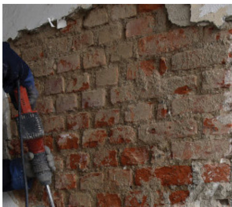
A meglévő vakolat eltávolítása
