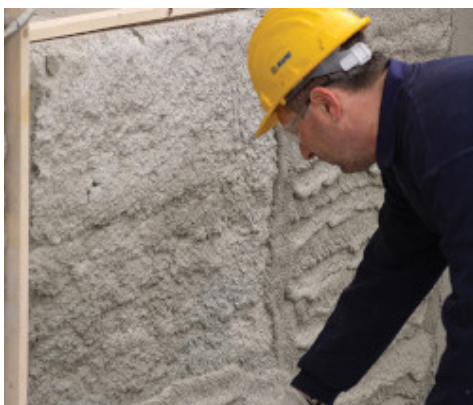
A PoroMap Szárítóvakolat felhordása vakológéppel
