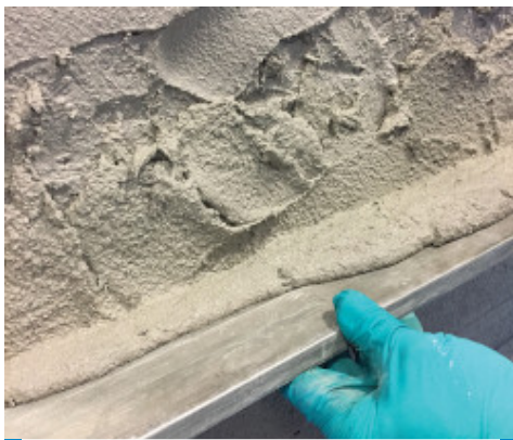
A PoroMap Szárítóvakolat lehúzása egyenes simítóval
