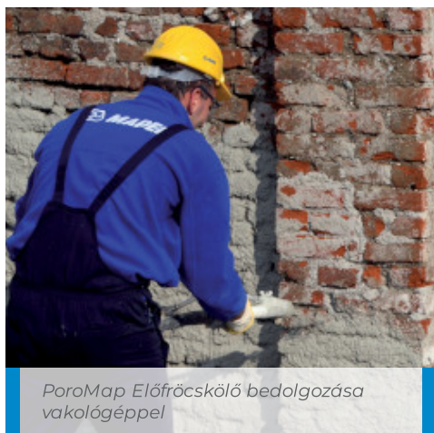
PoroMap Előfröcskölő bedolgozása Mapelastic Foundation-ra, antikondenzációs rendszerben
