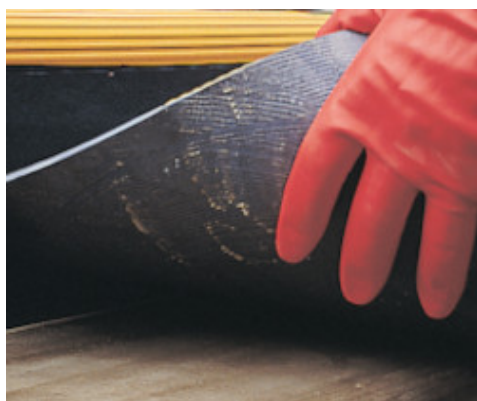
Gumi padlóburkolat ragasztása lépcsőre Adesilex LP-vel
