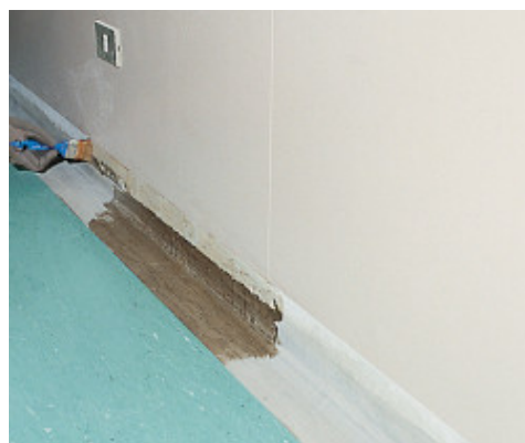
Lüni PVC szegélycsík fektetése Adesilex LP-vel
