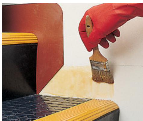
Gumi lábamat ragasztása Adesilex LP-vel
