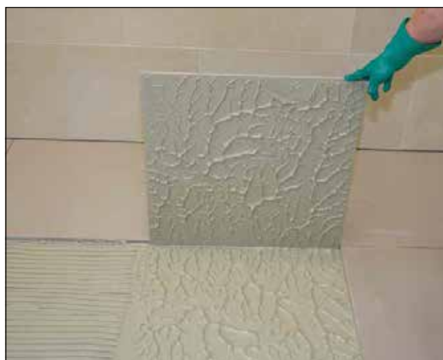
4 Optimális, szinte üregmentes fektetés Sopro FKM® XL-lel.
