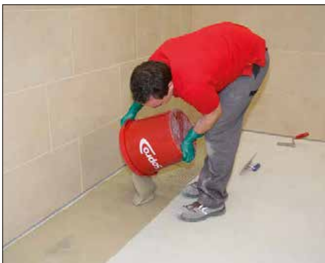
1 A Sopro FKM® XL kiöntése az előkészített aljzatra.
