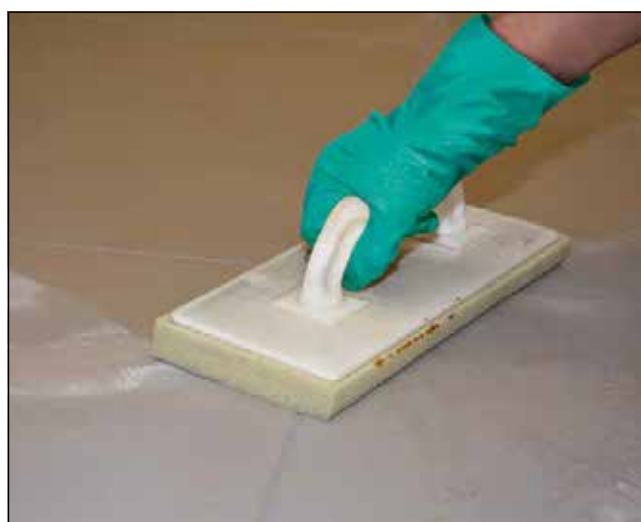
6 A csempeburkolat lemosása a Sopro fugázó anyag megfelelő szilárdsági fokának elérését követően.
