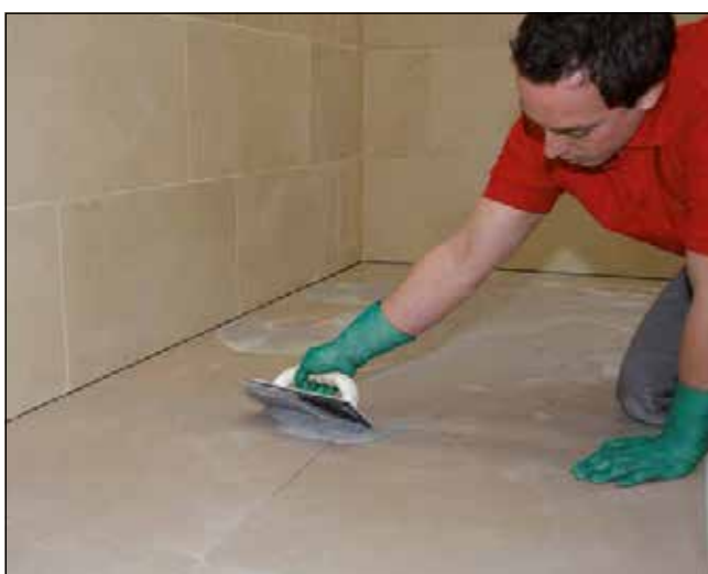
5 A felület kifugázása Sopro fugázó anyaggal (pl.: Sopro DF 10® Design FugeFlex, Sopro Brillant® PerlFuge).
