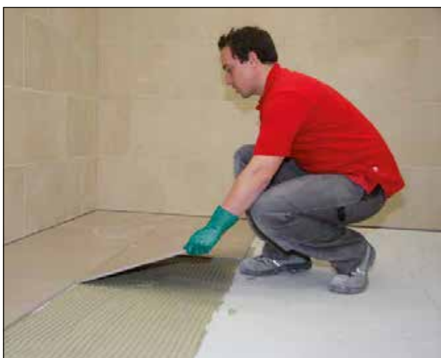
3 A nagy formátumú kőporcelán gres lap elhelyezése és helyére igazítása. A fugákat ki kell kaparni az anyag megszilárdulása előtt.
