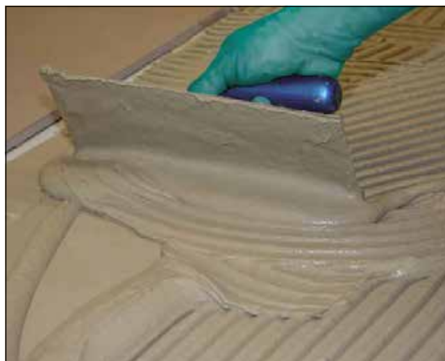
2 A selymes, folyékony Sopro FKM® XL-ből fésűgyázat kialakítása
